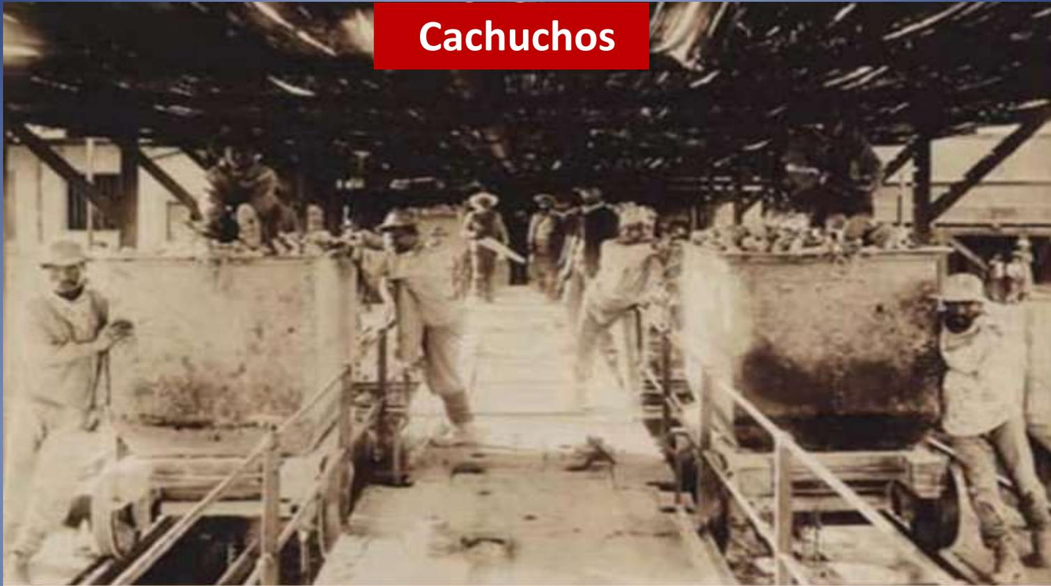
En esas refinerías, el caliche era pulverizado en chancadoras gigantes. Luego, el polvo se vertía en grandes estanques (cachuchos), donde era mezclado con agua y calentado. El líquido caliente fluía hacia diferentes tanques, desde donde se separaba el salitre líquido de otras impurezas. Finalmente, el salitre se concentraba, secaba, y se ponía en sacos de arpillera, para ser embarcado hacia Europa.
